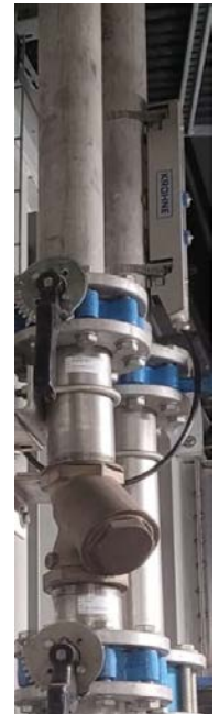
Ультразвуковий накладний реєчний датчик, встановлений на лінії охолодження
